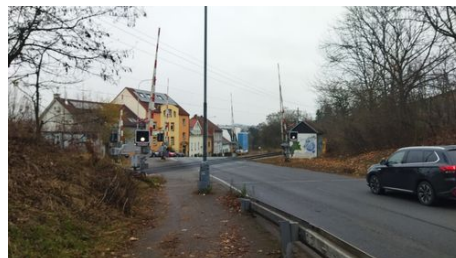
Železniční přejezd Samaritská ul.:
